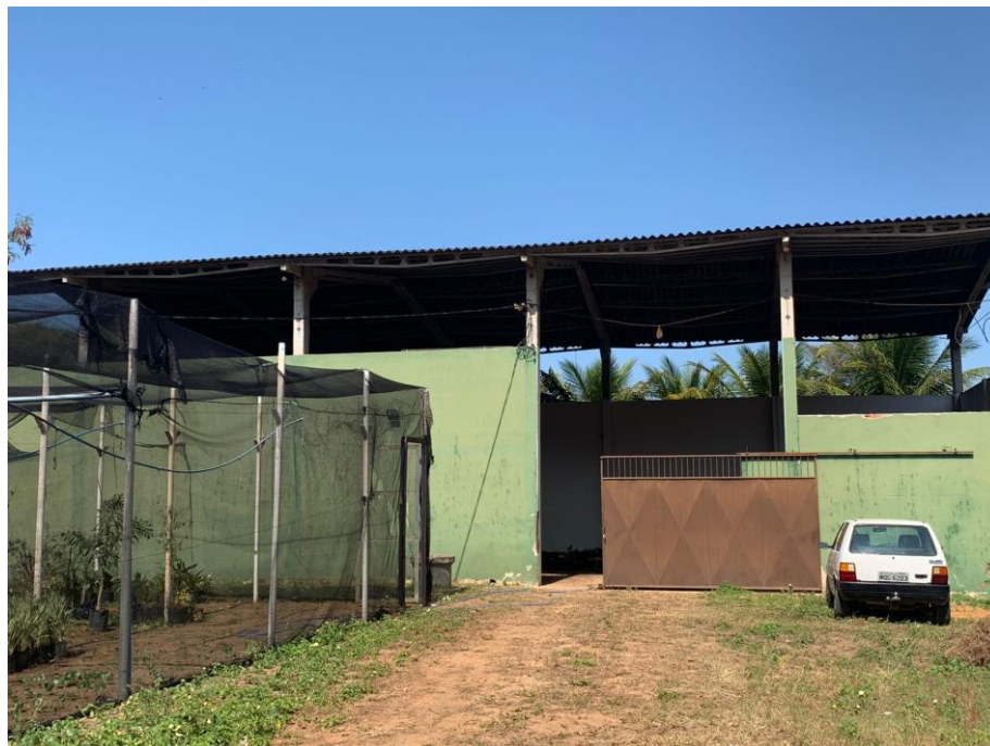
FACHADA GALPÃO VIVEIRO
