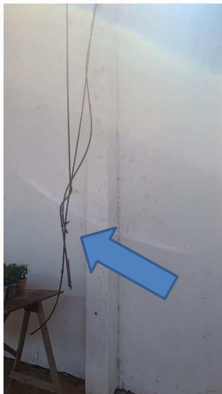
Tirante com estado avançado de oxidação e corrompido
