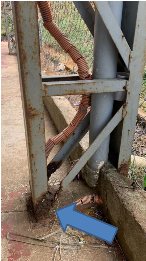
Oxidação uniforme presente nas peças
