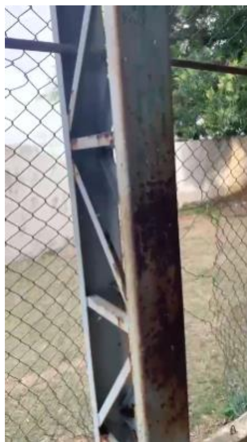
Oxidação uniforme presente nas peças
