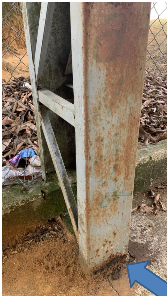
Oxidação uniforme presente nas peças
