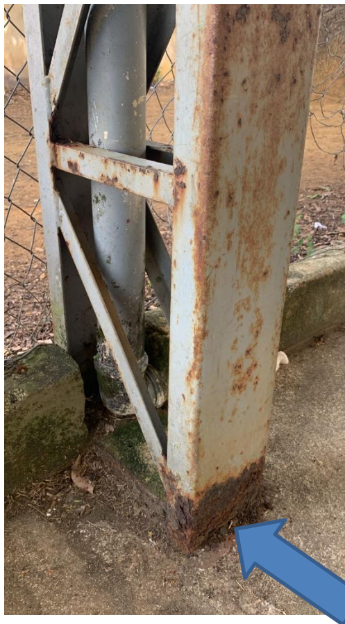
Oxidação uniforme presente nas peças
