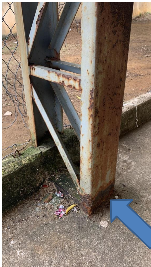
Oxidação uniforme presente nas peças
