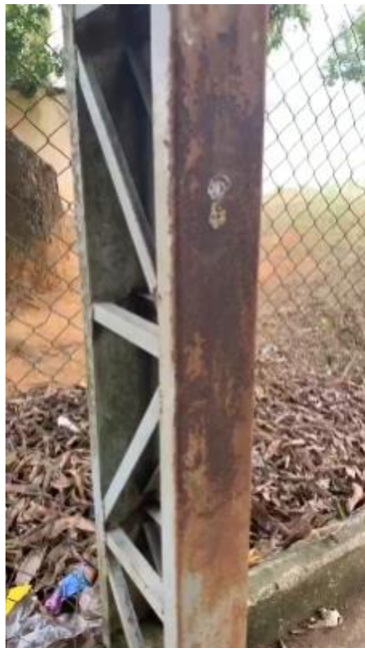
Oxidação uniforme presente nas peças
