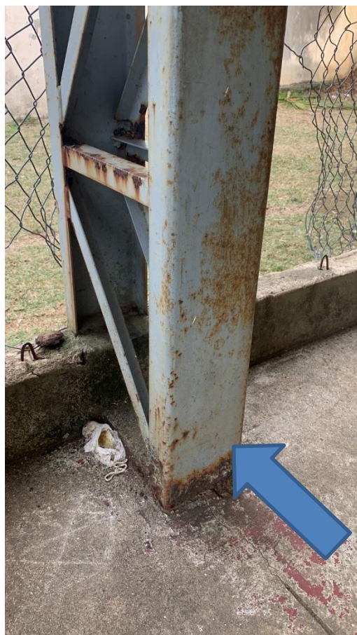
Oxidação uniforme presente nas peças
