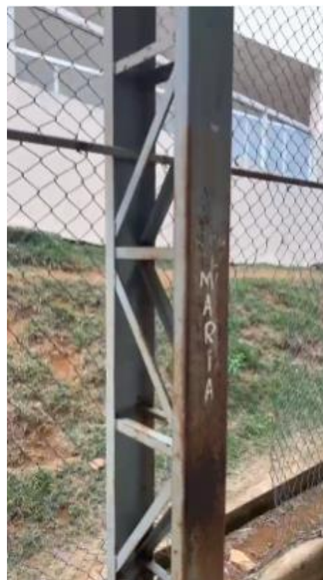
Oxidação uniforme presente nas peças
