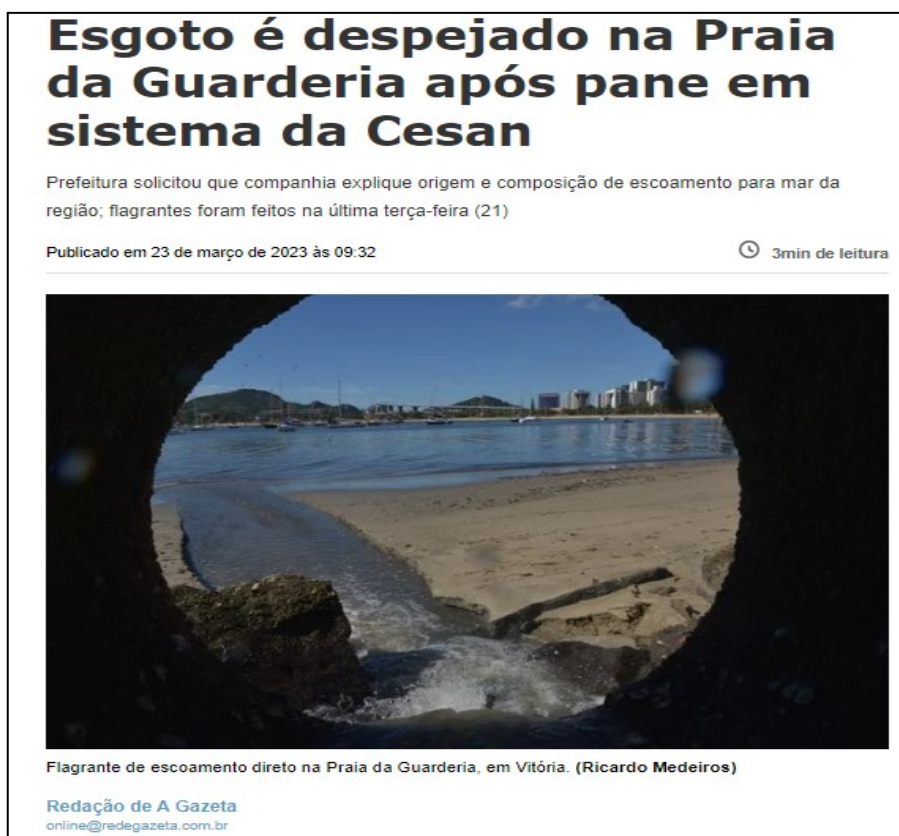
Figura 10: trecho de reportagem sobre vazamentos de esgoto em rede de drenagem.
