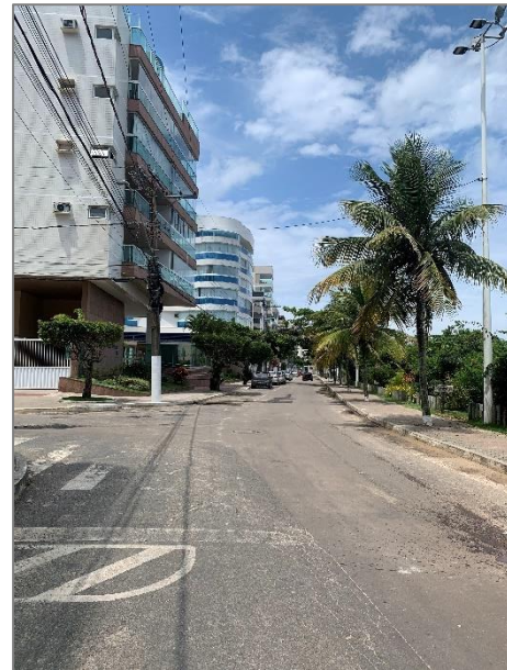
Figura 85: Foto das edificações na Av. Vina Del Mar.
