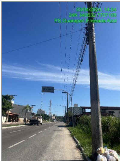
Figura 104: Falta de pavimentação em calçada na Av. Meaípe.
