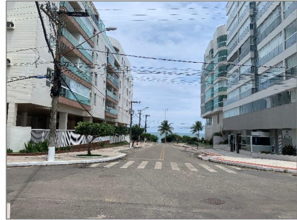
Figura 109: Calçadas regulares na Av. Miramar.
