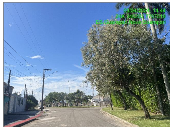
Figura 101: calçadas sem pavimentação na rua João de Barro.
