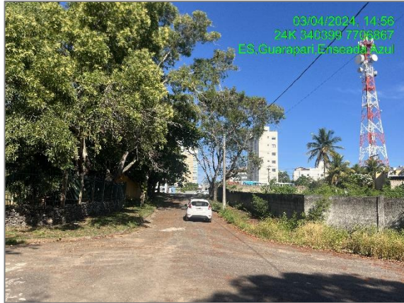
Figura 102: calçadas sem pavimentação na Alameda Tandeco.
