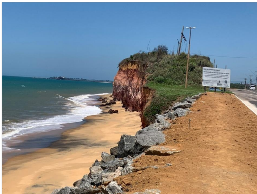
Figura 119: Litoral de Meaípe, ao fundo a formação de falésias e parte da obra de contenção da erosão.
