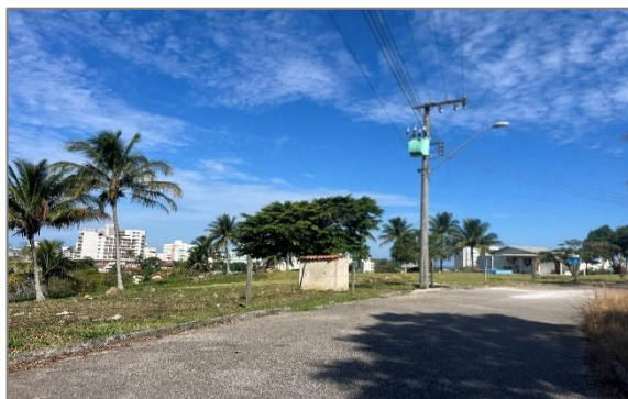
Figura 116: Foto da rua João de Barro sem dispositivos de drenagem.
