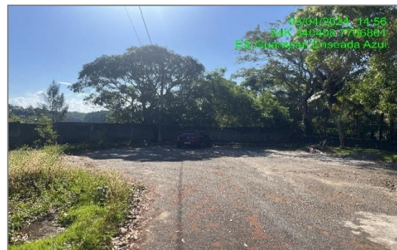
Figura 117: Foto da Alameda Tandeco sem dispositivos de drenagem.
