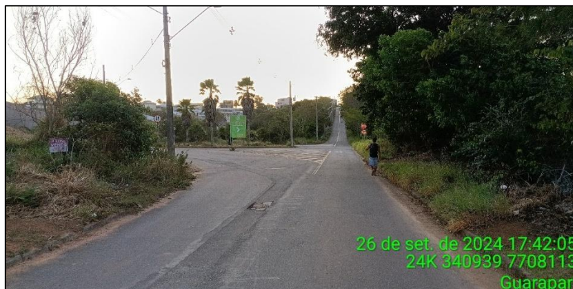
Figura 32: Trecho da Avenida Norte Sul – aproximadamente à 500 m da Avenida Meaípe.
