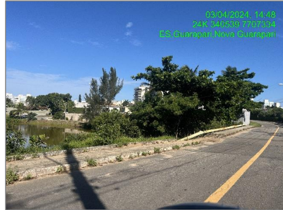
Figura 103: calçada da rua La Paloma.
