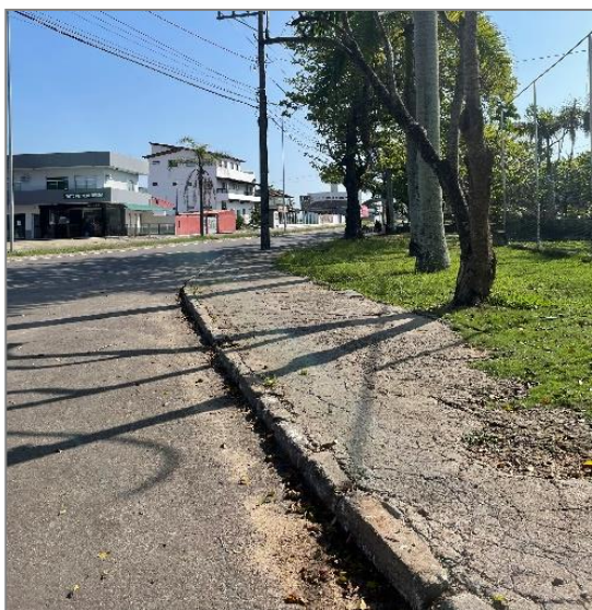
Figura 71: Calçada degradada na Av. Meaípe. Figura 72: Calçada degradada na Av. Meaípe.
