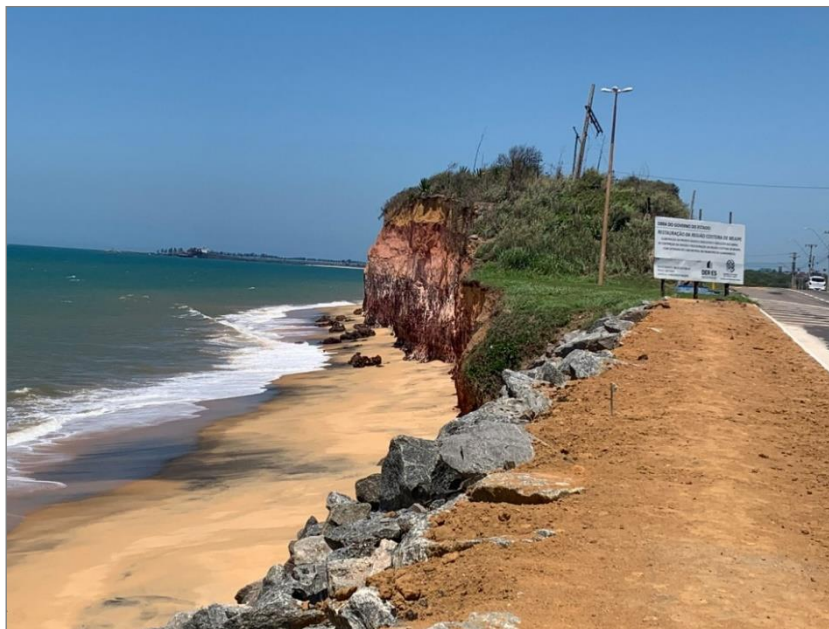
Figura 80: Litoral de Meaípe, ao fundo a formação de falésias e parte da obra de contenção da erosão.
