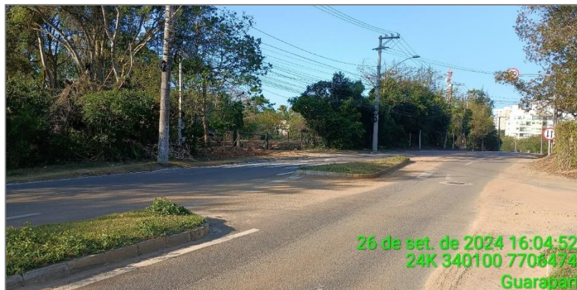
Figura 11: Trecho da Avenida Antônio Rosa Nascimento – sentido leste.
