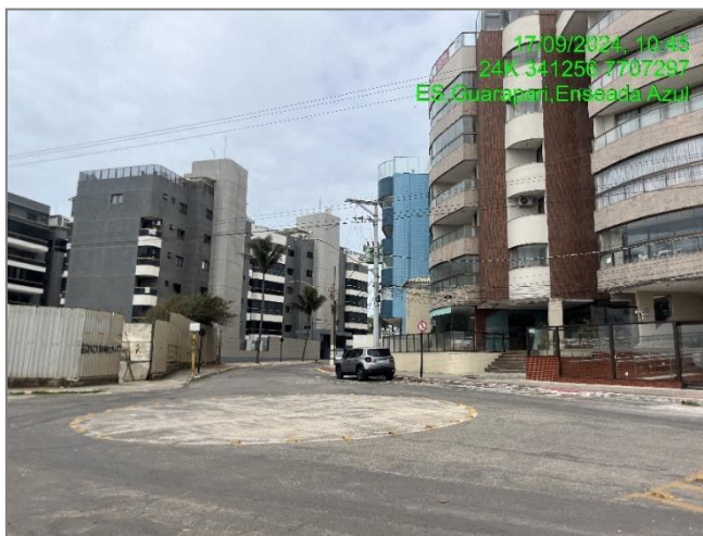
Figura 74: Calçadas regulares na Av. Viña Del Mar.
