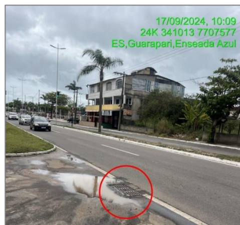
Figura 78: Dispositivo de drenagem na Avenida Meaípe.
