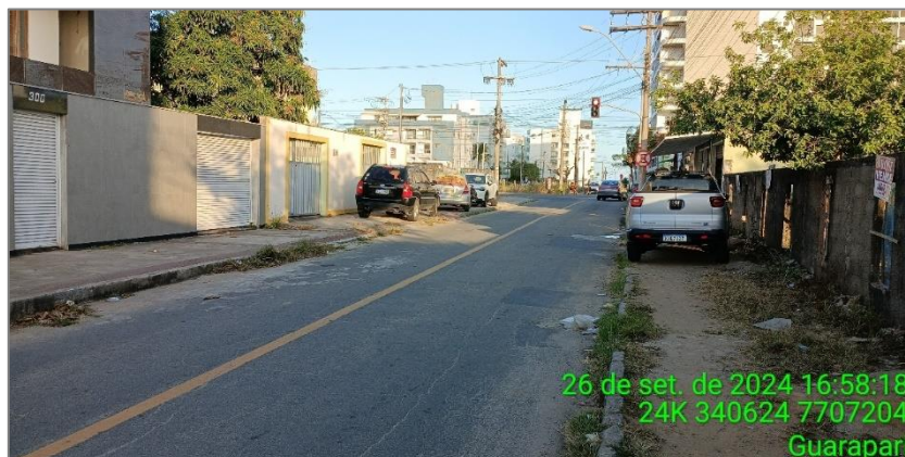
Figura 18: Trecho da Rua La Paloma à oeste da Avenida Meaípe.
