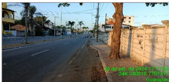
Figura 28: Ponto de ônibus 5 em porção da A. Meaípe, sentido norte.
